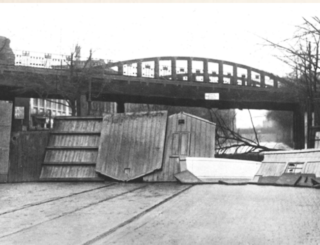
Eine Barrikade an der Hochbahnbrücke Fuhlsbüttler Straße
